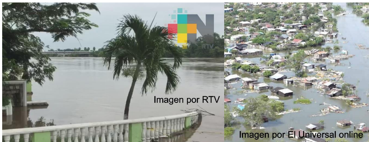
Figura 1. Desbordamiento de ríos y sus afectaciones.
